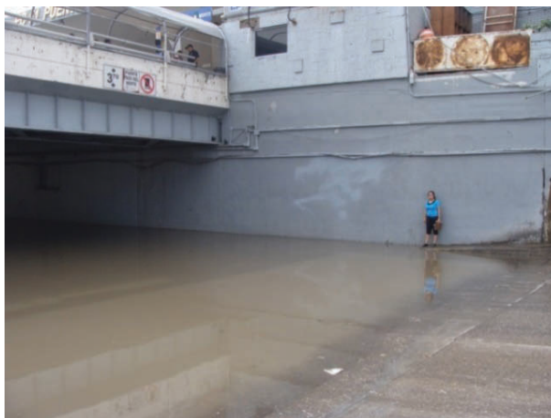
Fotografía 1: Paso a Desnivel de la Av. Ing. Bernardo Norzagaray, Fuente: IMIP 2013.
