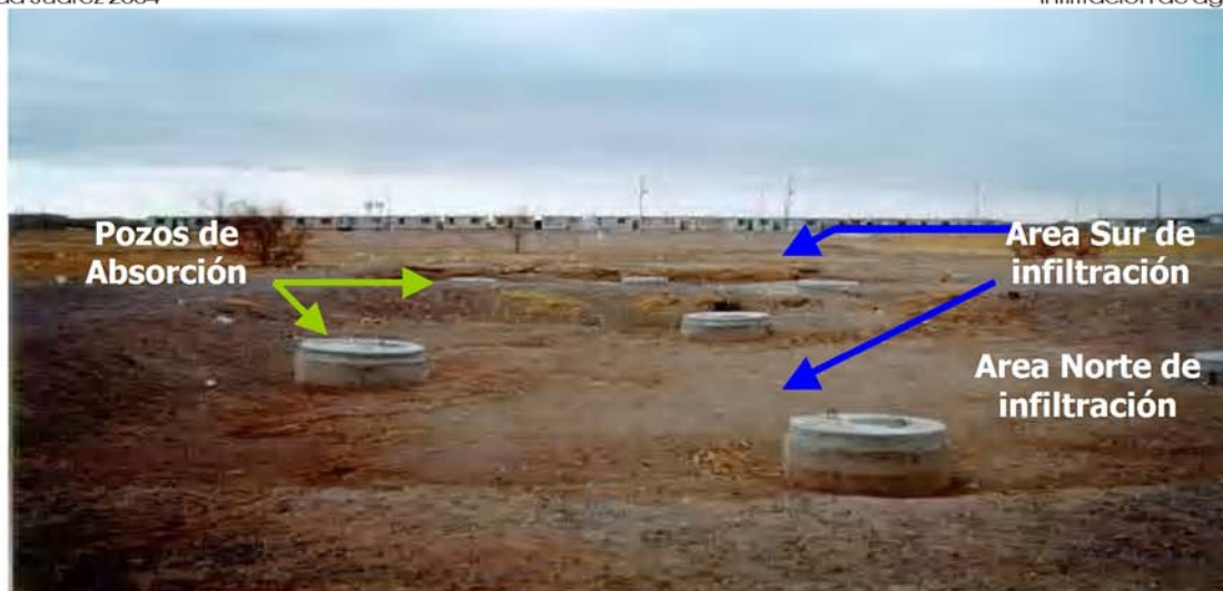
FOTO VI.6.11 (3). ZONA DE POZOS DE ABSORCIÓN EN FRACCIONAMIENTO ROMA
